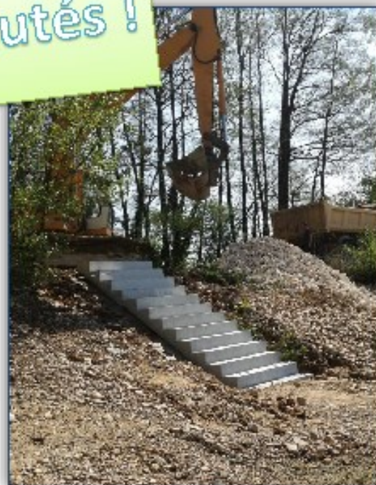
Escalier préfabriqué en atelier prêt à poser, coût réduit !
