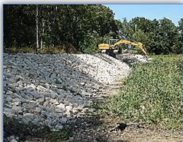
Empierrement de digue
