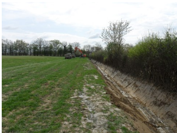
Curage de fossé
