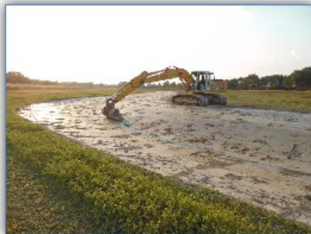
Curage de pêcherie avec évacuation de la terre en bordure
